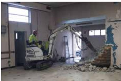
Les travaux de rénovation de la salle des fêtes ont démarré au mois d'octobre. La scène et le bar, entièrement en béton, ont donné du fil à retordre aux démolisseurs, mais ils en sont venus à bout à grand renfort de burin hydraulique. L'agrandissement des ouvertures est terminé et les équipements intérieurs ont été déposés (sanitaires, gaines de ventilation, équipements électriques et de secours, mobilier fixe, etc.)
