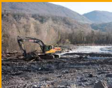
— Suite aux crues des 4 et 5 janvier, les opérations d'évacuation d'embâcles ont débuté très rapidement —
